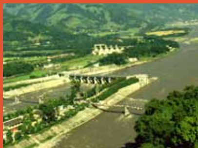
Dujiangyan Irrigation Project 都江堰水利工程
